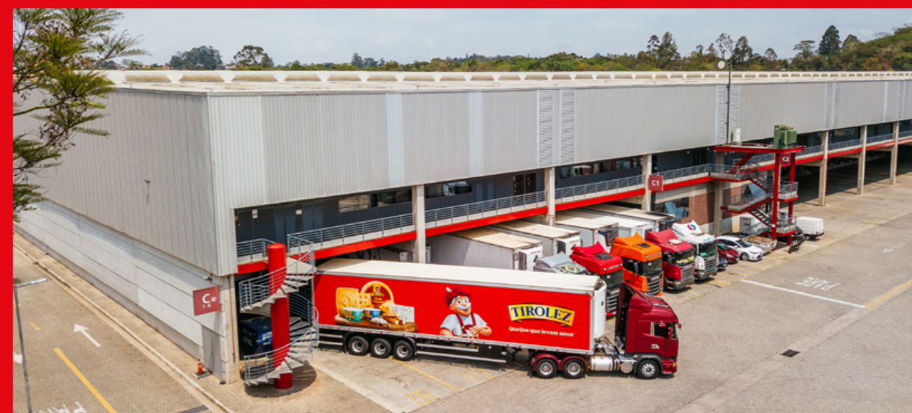
Centro de Distribuição
